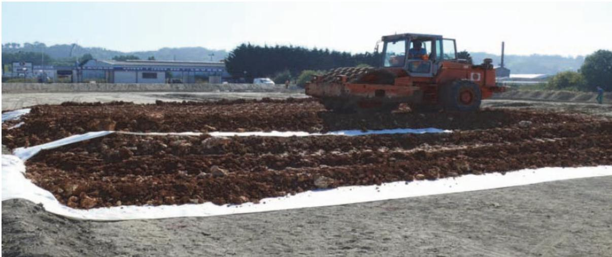
Figure 4. Mise en place du géotextile de renforcement au niveau de l'assise de la digue périphérique.
